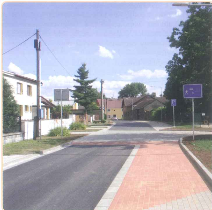
Lokalita ulice Budovcova byla kompletně zrekonstruována v celé své délce tak, aby odpovídala potřebám provozu.
